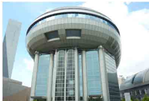
東京都下水道局 虹の下水道館（有明水再生センター）
